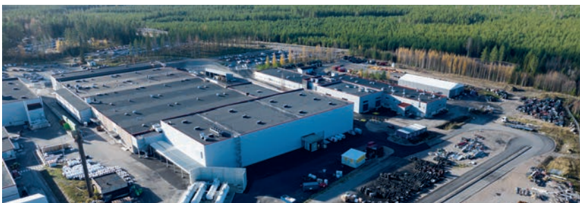
Das Getriebewerk befindet sich zwischen dem technischen Zentrum und dem Montagewerk. Auch die Außenanlagen wurden neu gestaltet. Und dank des neuen Nordtors konnte der Lkw-Verkehr um das Getriebewerk auf weniger als die Hälfte reduziert werden.
